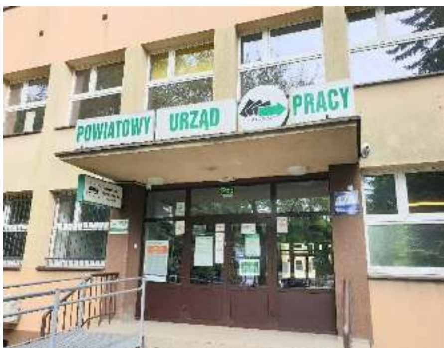
Wejście do budynku od ul. Krasickiego
